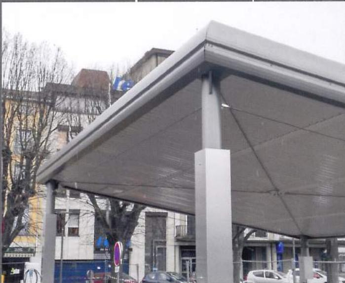
Bandeau moulure réalisé par pliage/croquage
