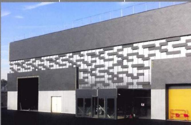
Bardage polycarbonate alvéolaire avec superposition de panneaux de façade Natura
