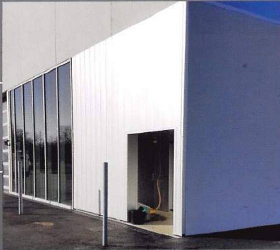
Lames de bardage aluminium anodisé
