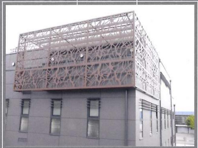
Façade en panneaux fibre-ciment Equitone et sur-façade acier thermolaqué
